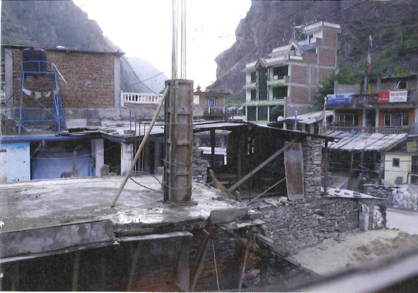
Syabrubesi in aanbouw
