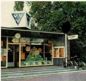
VVV Kantoor aan de Steenhoffstraat 9a
