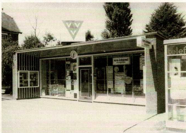
VVV Kantoor aan de Steenhoffstraat 9a
