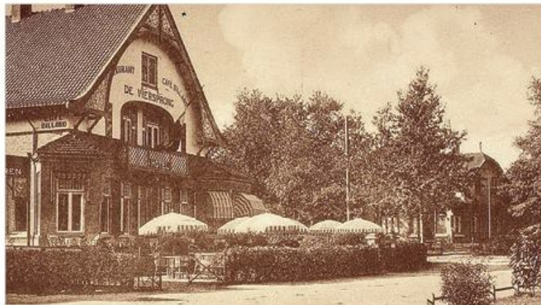
De Viersprong, ooit gevestigd aan het Nieuwerhoekplein.
