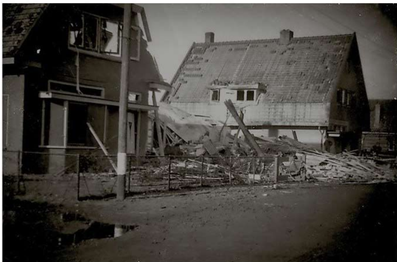
■ 1941: Postweg 39 en omliggende huizen lopen grote schade op door luchtaanvallen van de Duitsers.
