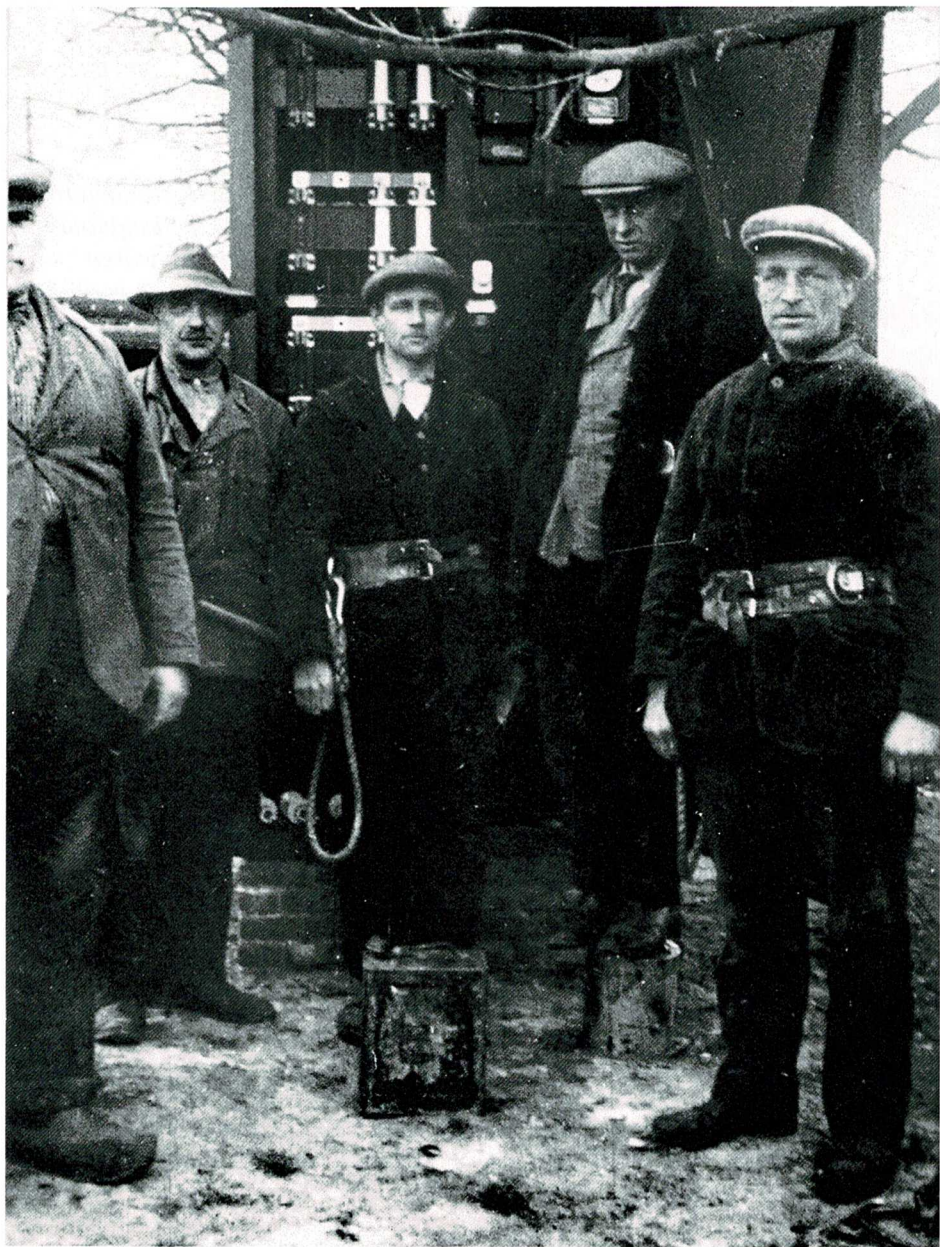
De montageploeg van de elektrische bovenleiding, v.l.n.r. onbekend (half afgebeeld), v.d. Kraats uit Soesterberg, Willem van de Grift, Kees Hooft uit Eemnes en Hendrik Kok van de Veenzoom. Foto collectie G.W. van de Grift.
