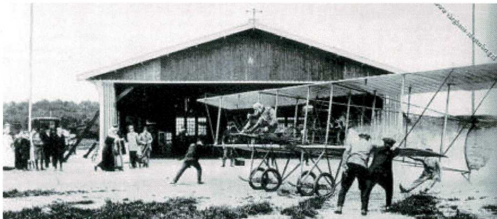
De Brik op Soesterberg.
