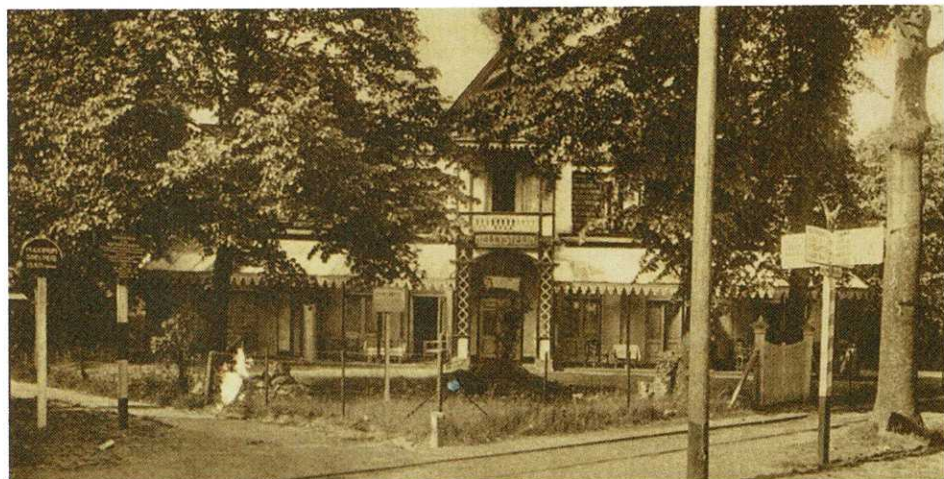
Nelleijsteijn, naast pension was het ook een tijdje dokterswoning met zelfs ziekenzaaltje
