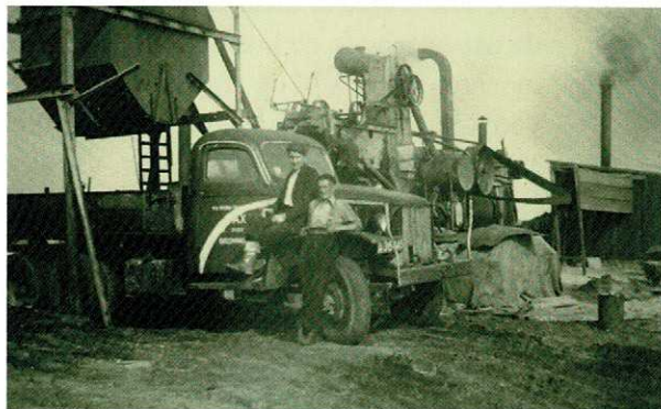
Ter plaatse wordt beton gefabriceerd.
