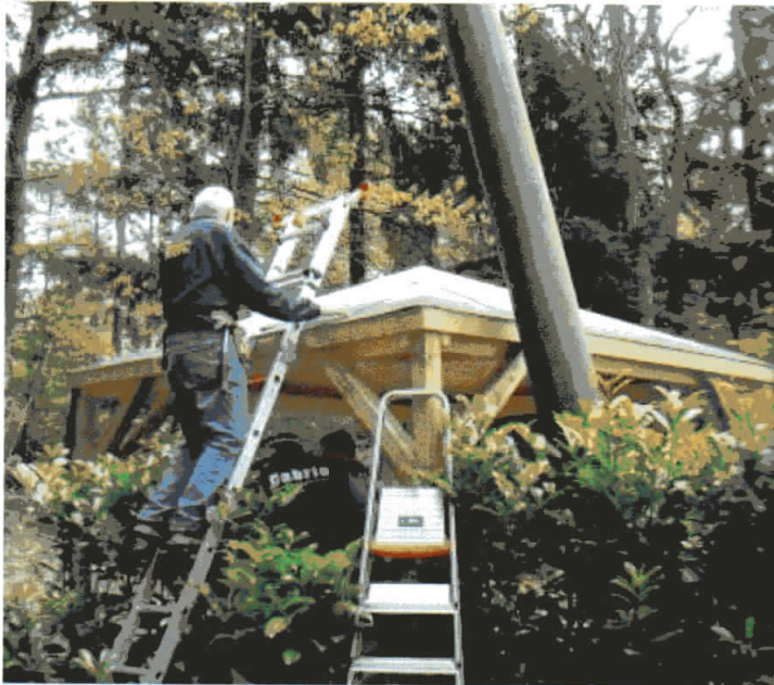
Een degelijk afdak boven de technische ruimte naast het toneel.
