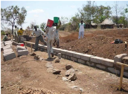
De bouw is begonnen
