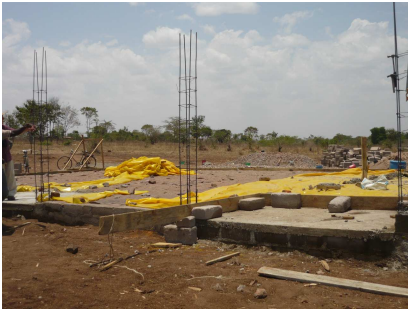
17-09-2009 De constructie voor de pilaren aan de voorkant van de polikliniek
