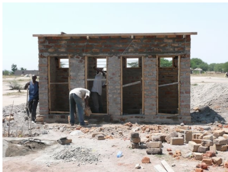
Toiletgebouw in aanbouw
